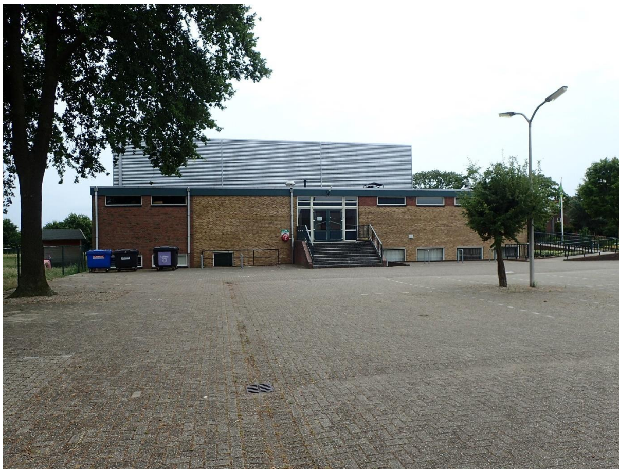
Figuur 1. Het huidige Dorpshuis 't Kempken vanaf de naastgelegen parkeerplaats (foto: RAAP, 29 juni 2023).
